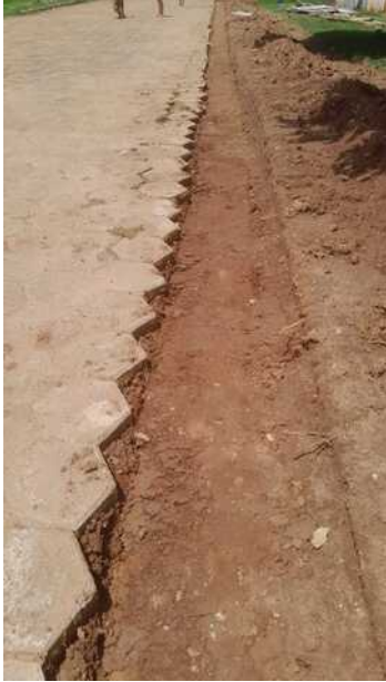
COMPACTAÇÃO DE SOLO PARA MEIO FIO, RUA TRANCREDO NEVES
