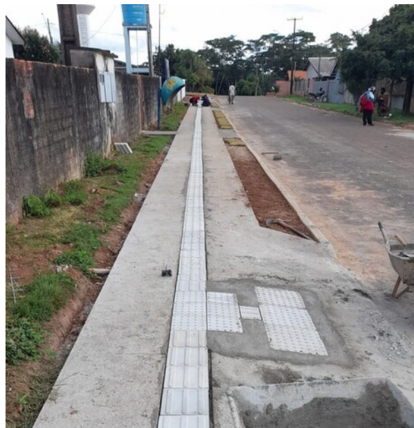
ASSENTAMENTO DE PISO PODOTÁTIL ESCOLA ESTADUAL DISTRITO DE QUERENCIA
