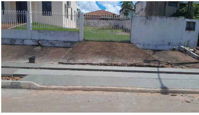
RAMPA VEICULOS ASSEMBLEIA DE DEUS , AV CARLOS GOMES ( QUERENCIA. )
