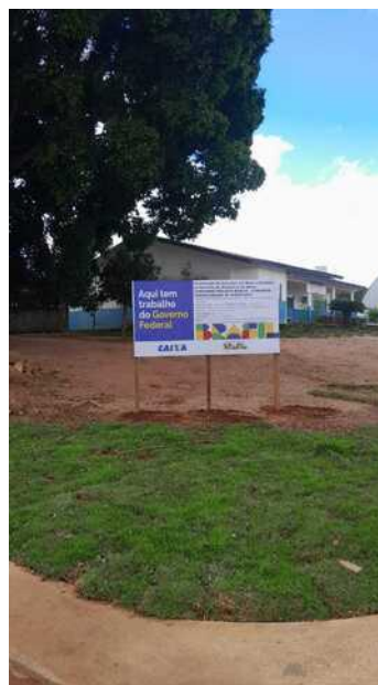
PLACA DA OBRA INSTALADA NO LUGAR QUE O ENGENHEIRO FISCAL SOLICITOU
