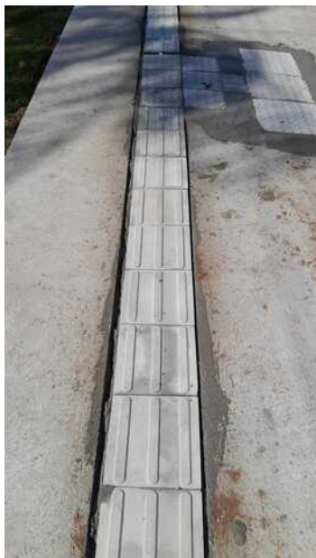
ASSENTAMENTO DE PISO PODOTÁTIL RUA TRANCREDO NEVES ESCOLA ESTADUAL ESTÁCIO DE SÁ ( QUERENCIA )
