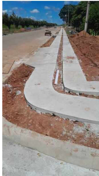
CALÇADA CONCRETADA AV CARLOS GOMES COM RAMPA CADEIRANTES ( QUERENCIA )
