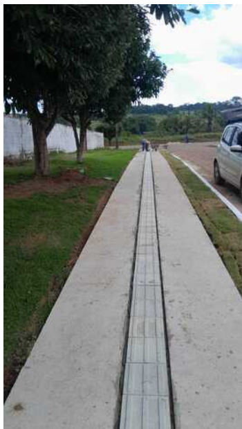
INSTALAÇÃO DO PISO PODOTÁTIL
