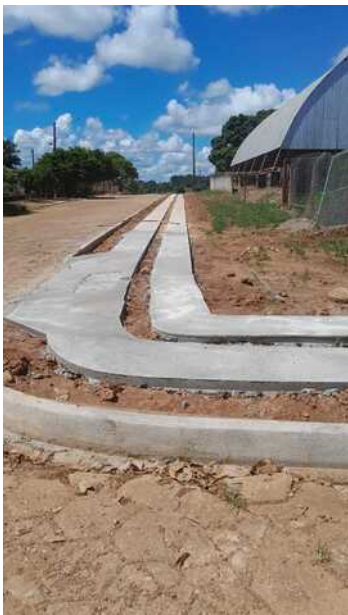
CONCRETAGEN DE CALÇADAS COM RAMPA CADEIRANTES , RUA COSTA E SILVA ( QUERENCIA )
