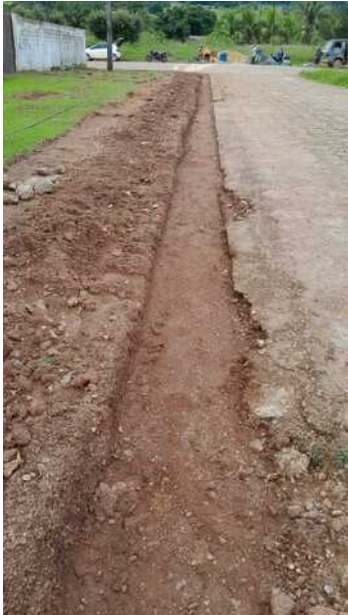
COMPACTAÇÃO BASE MEIO FIO RUA TRANCREDO NEVE
