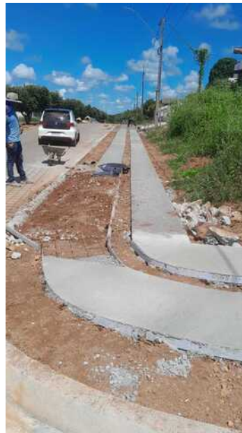
CALÇADA CONCRETADA AV CARLOS GOMES COM RAMPA CADEIRANTES ( QUERENCIA )
