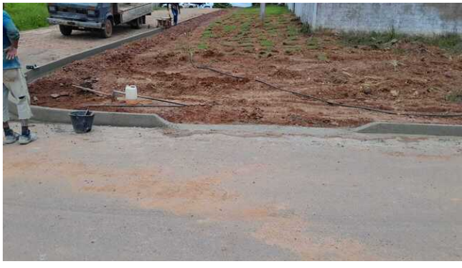
REBAIXAMENTO DE MEIO FIO PARA RAMPA CADEIRANTES, AV CARLOS GOMES
