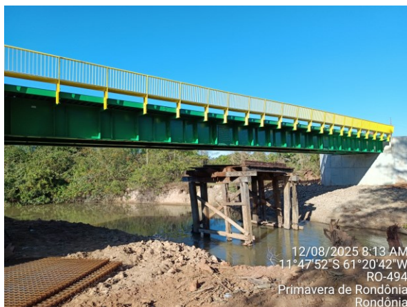
Imagem 2: ponte executada na linha 33.
