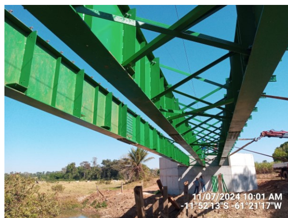
Imagem 3: ponte executada na linha 41.
