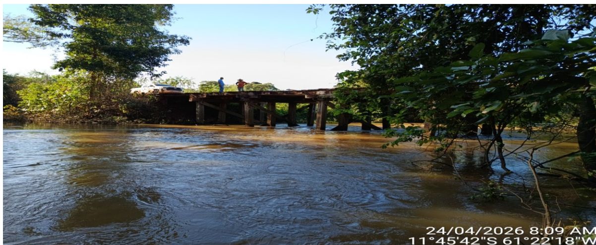
Imagem 1: Estrutura atual da ponte de madeira localizada na Linha 37, Km 3,40, zona rural do Município de Primavera de Rondônia/RO.
