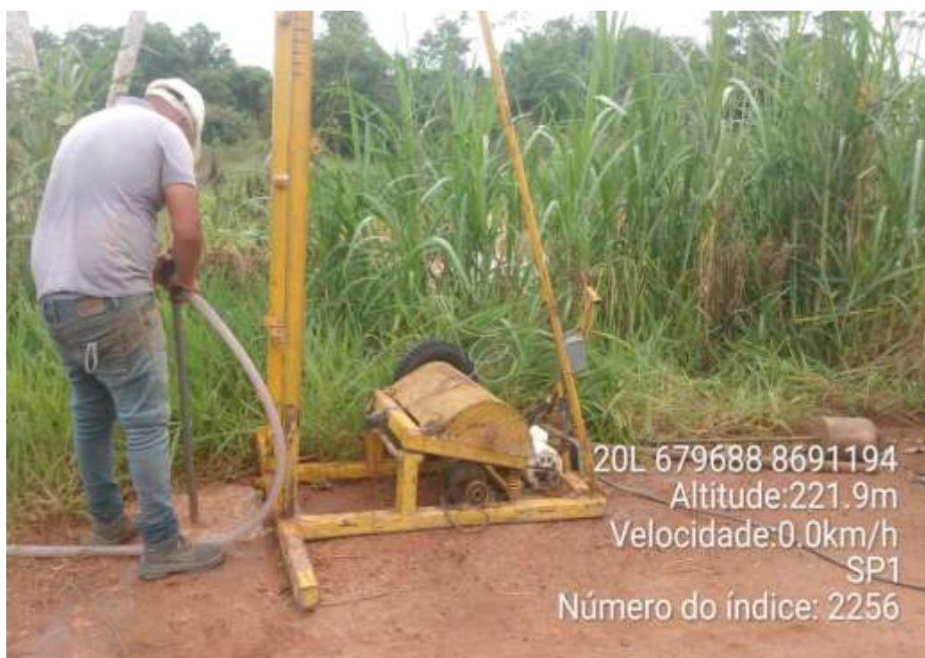
Foto 1: Execução do Furo SMf-1 através da sondagem Mista na ponte da Linha 37, Gleba Corumbiara, Setor Abaitará, Zona Rural, Município de Primavera de Rondônia.
